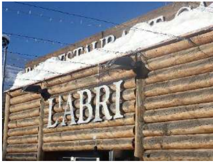
Enseigne avec éclairages directs visibles, dans le but de pouvoir lire l'enseigne de nuit.
