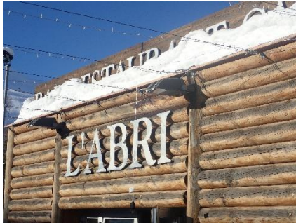
Enseigne avec éclairages directs visibles, dans le but de pouvoir lire l'enseigne de nuit.
