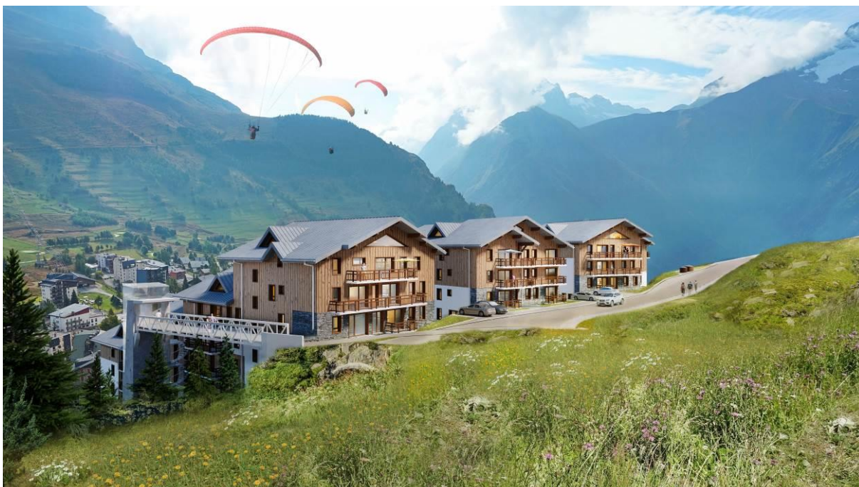
Vue depuis l'amont du site
