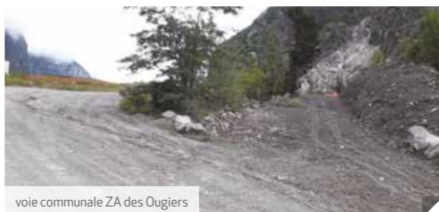
aménagement du tourne à gauche aux Ougiers
