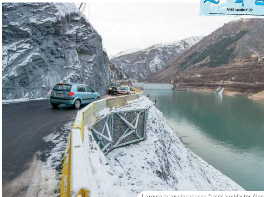
La route terminée redonne l'accès aux Hautes Alpes
